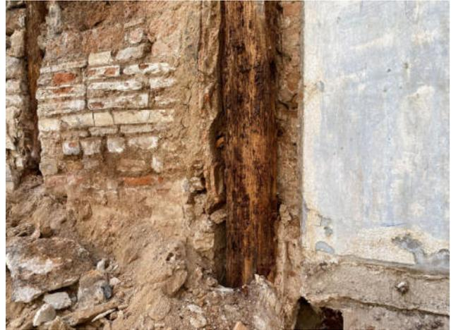
Fig.28. Vista detalle de pie derecho de madera atacado por insectos xilófagos y sin apoyo en el muro de mampostería
