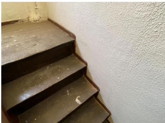
Fig.61. Detalle desplazamiento hacia la derecha (izquierda en la foto) de la escalera de P02-P03
