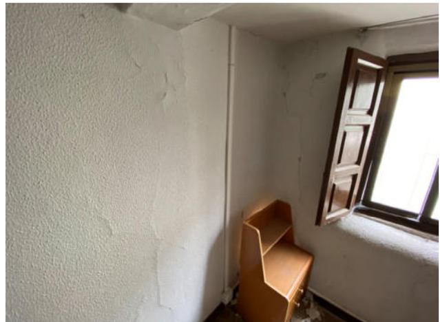
Fig.120. Altura de peto de ventaja a escasa altura con respecto al suelo terminado en planta tercera
