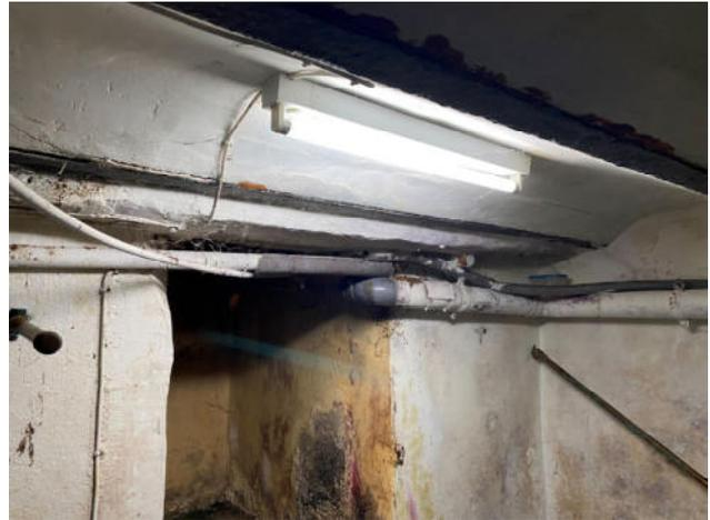
Fig.136. Vista general del sótano sin elementos de ventilación
