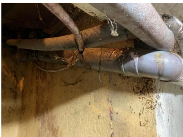
Fig.107. Recorrido de colector de aguas residuales por el techo del sótano hasta arqueta
