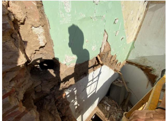
Fig.100. Medianera derecha sin ningún tipo de aislamiento térmico vista desde el exterior, lo que se puede interpolar a todo el inmueble
