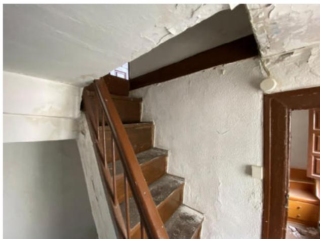
Fig. 121. Altura de barandilla en escalera de muy baja altura y mucha distancia entre los barrotes verticales
