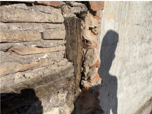
Fig.35. Vista detalle de un pilarote y un puente perteneciente al entramado de madera atacado por xilófagos
