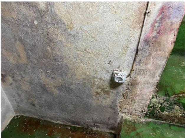
Fig.139. Restos de moho en sótano de planta sótano por el ascenso de la humedad en los muros
