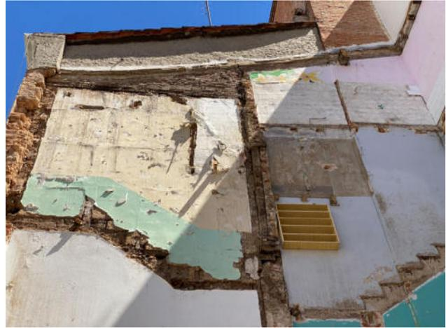
Fig.34. Vista general de medianera revestida en la que se aprecia un desplazamiento de un pie derecho al exterior
