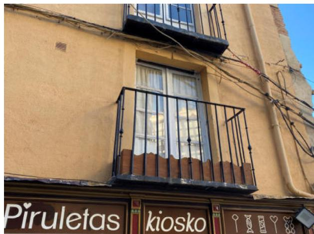
Fig.151. Cableados en la fachada a la altura de la planta segunda
