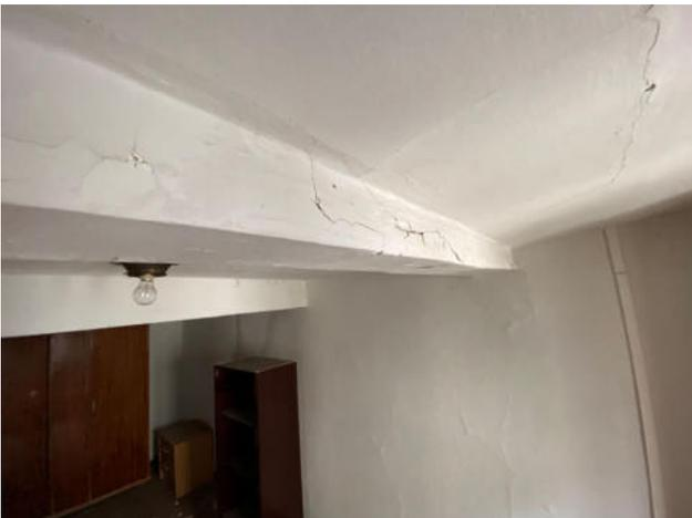
Fig.25. Planta tercera. Grietas en cielos rasos de caña y escayola y grietas en revestimiento de viga de yeso
