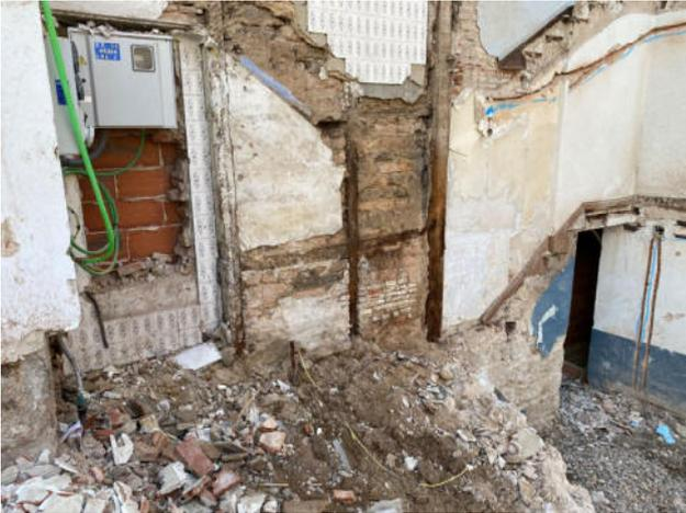
Fig.27. Vista general de medianera en la que se ven dos de los tres pies derechos y el entramado de madera
