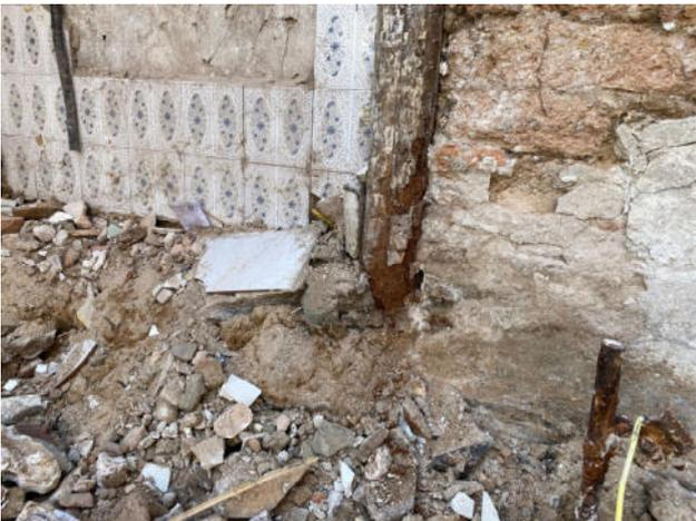
Fig.31. Vista detalle de pie derecho de madera atacado por insectos xilófagos y sin apoyo en el muro de mampostería
