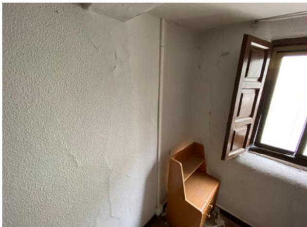
Fig.69. Grieta en interior de planta tercera en el lado derecho de la fachada (izquierdo en la foto)
