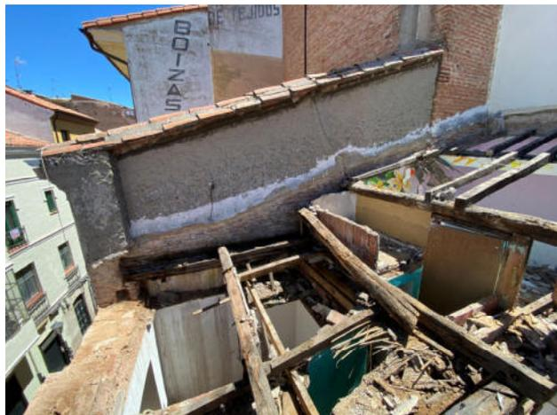
Fig.50. Borde de cubierta recto por apoyarse sobre muro de 15 cm que evita las deformaciones en los vanos entre las vigas
