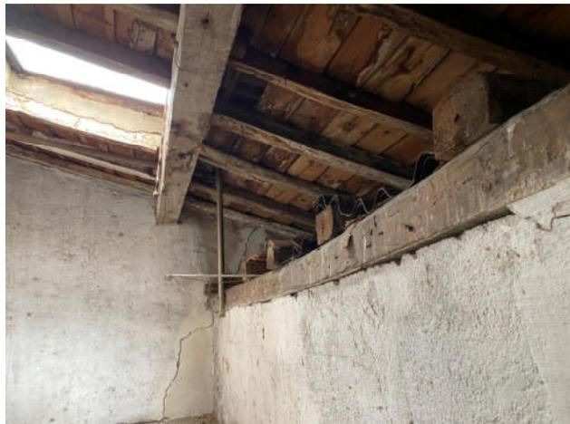
Fig.18. Planta bajocubierta. Grieta diagonal en medianera derecha hasta el punto superior de la cubierta
