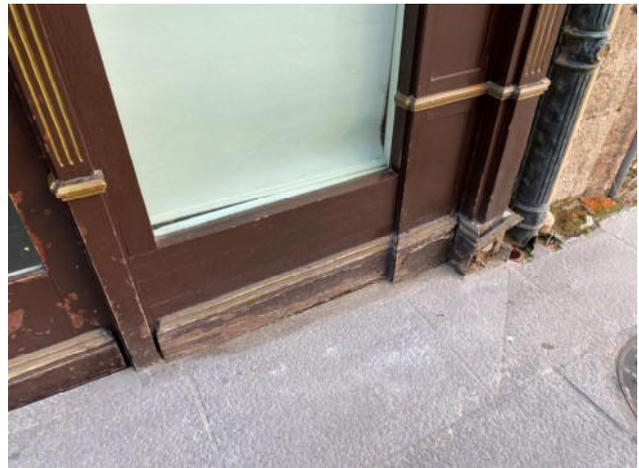
Fig.147. Falta de mantenimiento en carpinterías de madera del escaparate
