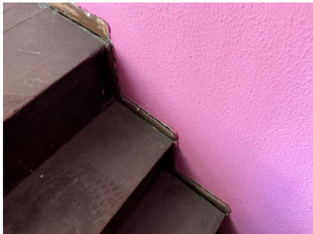
Fig.58. Detalle desplazamiento hacia la derecha (izquierda en la foto) de escalera entre P01-P02
