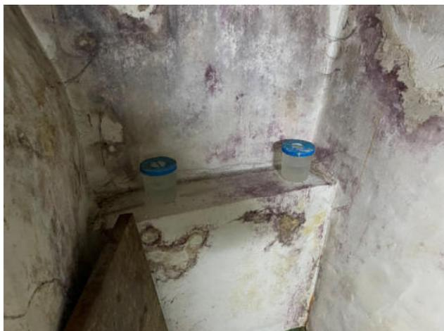
Fig.42. Deshumificadores en el interior del sótano para reducir en la medida de lo posible el alto grado de humedad en el ambiente
