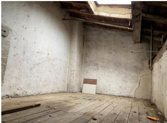
Fig.17. Planta bajocubierta. Grieta diagonal en medianera derecha y grieta en encuentro con patinillo de ventilación
