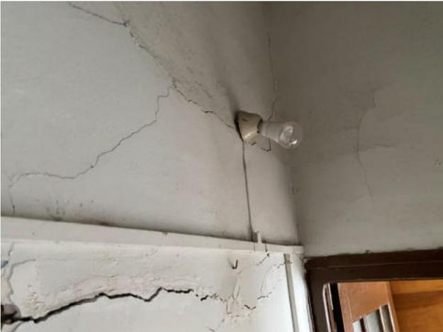
Fig.109. Instalación eléctrica por canaleta exterior para la conexión de una bombilla colocada en superficie
