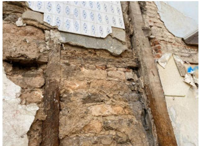
Fig.32. Vista detalle de puente de madera entre pie derecho y pilarote de madera atacado por insectos xilófagos
