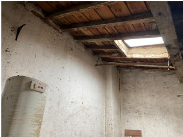
Fig.91. Deformación entre vigas de viguetas de madera en cubierta
