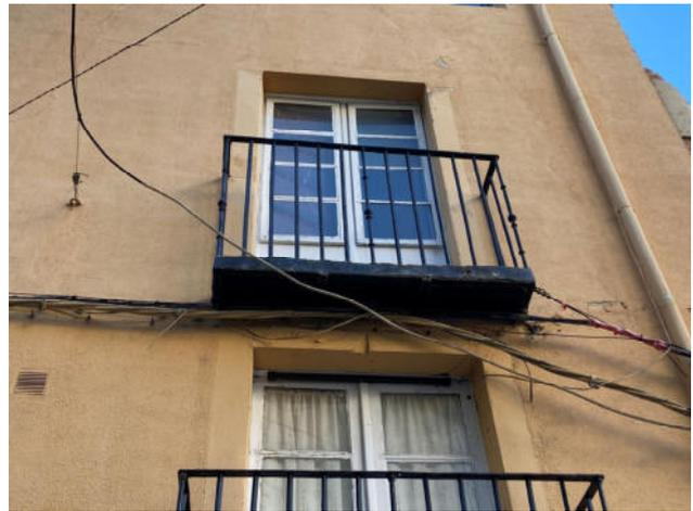
Fig.90. Pintura en losa de balcón metálica sobre oxido en la planta primera
