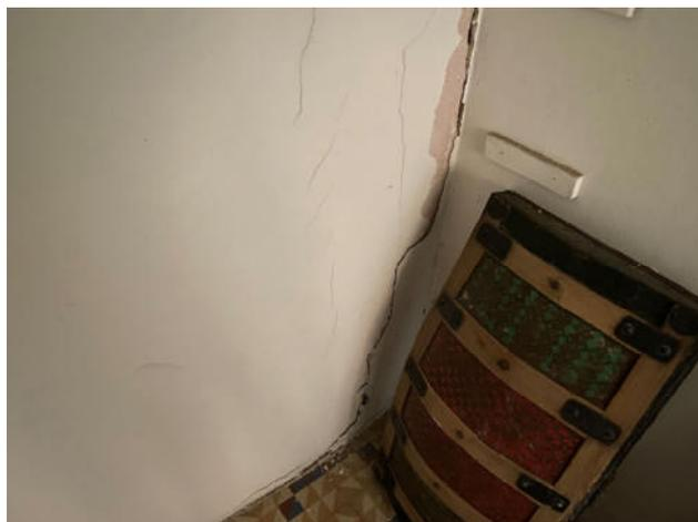
Fig.20. Planta cuarta. Grieta diagonal en medianera derecha y grieta de separación en encuentro con tabique en estancia 02
