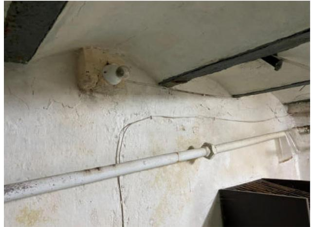
Fig.102. Suministro de agua potable en interior de sótano
