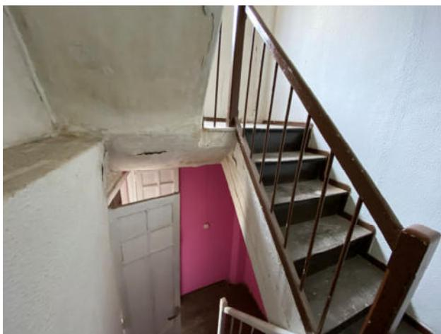
Fig. 122. Altura de barandilla en escalera de muy baja altura y mucha distancia entre los barrotes verticales
