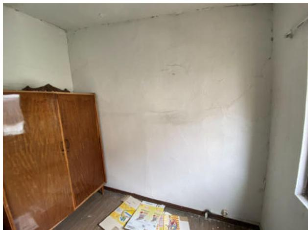
Fig.22. Planta cuarta. Grietas en diagonal en medianera derecha en estancia 02
