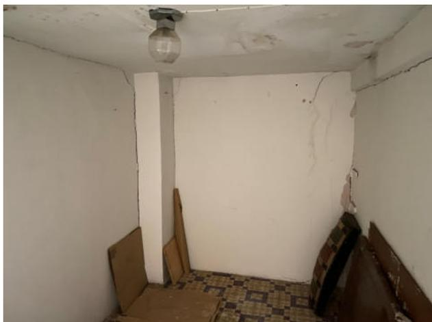
Fig.19. Planta cuarta. Grieta diagonal en medianera derecha y grieta en encuentro con patinillo de ventilación en estancia 02
