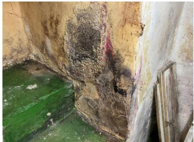
Fig.140. Restos de moho en sótano de planta sótano por el ascenso de la humedad en los muros
