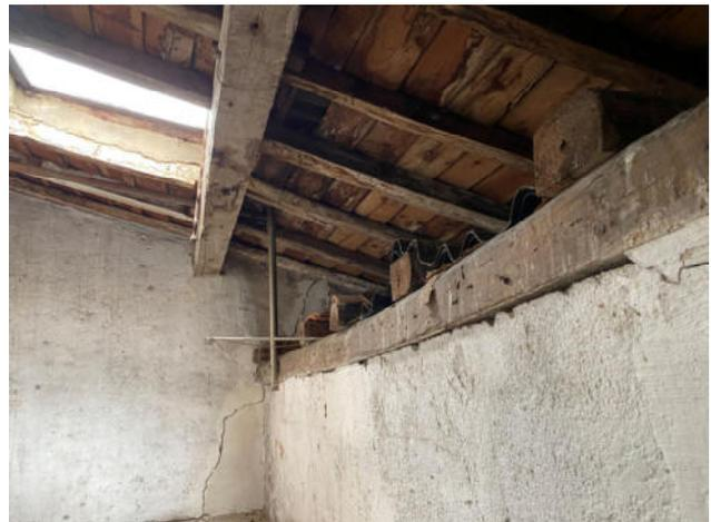
Fig.92. Deformación entre vigas de viguetas de madera en cubierta
