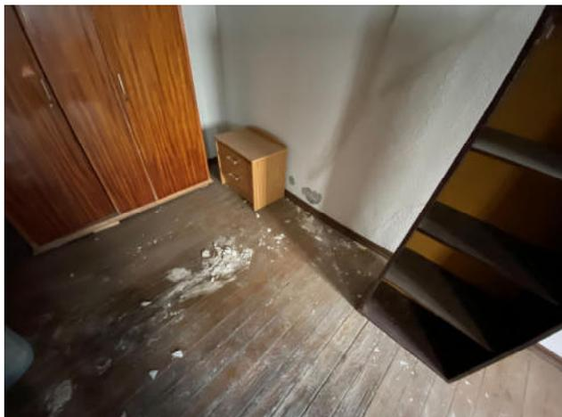
Fig.47. Deformaciones en el forjado de la planta tercera donde existe suelo original
