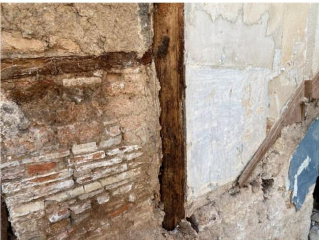
Fig.29. Vista detalle de pie derecho de madera atacado por insectos xilófagos y sin apoyo en el muro de mampostería
