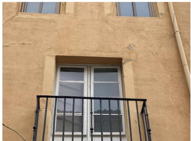
Fig.06 Grieta en la ventana balconera de la planta segunda
