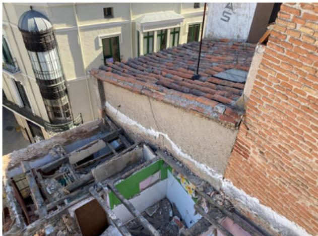
Fig.49. Deformaciones de cubierta en los vanos entre las vigas de madera que soportan la cubierta
