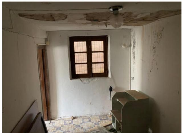
Fig.97. Daños en cielo raso de estancia 02 por filtraciones de cubierta y de espacio bajocubierta
