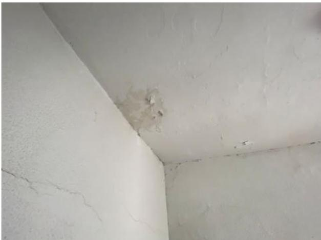
Fig.55. Restos de daños de humedad proveniente de cubierta en techo de estancia 01 sin reparar
