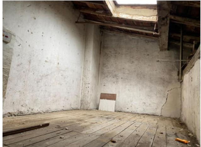
Fig.52. Restos de humedades en zona de hueco de lucernario y suelo de planta de bajocubierta
