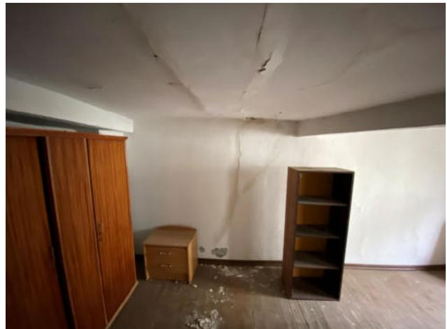
Fig.76. Grietas reparadas y sin reparar en la medianera de la estancia 01 de la planta tercera
