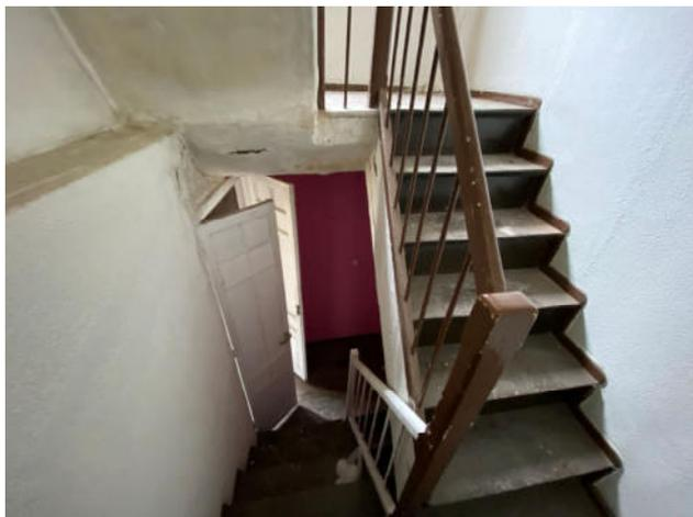
Fig.59. Vista general escalera de madera de P02-P03 con desplazamiento a la izquierda
