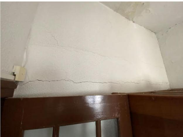
Fig.13. Planta cuarta. Grieta horizontal en estancia 01 en tabique de separación con estancia 02
