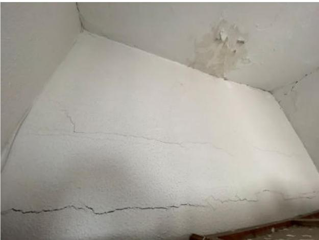
Fig.169. Daños en falso techo de la estancia 01 de la planta cuarta por filtraciones de cubierta
