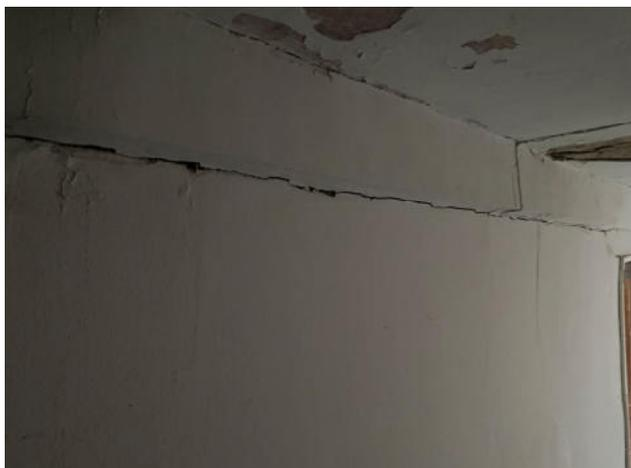
Fig.09. Planta cuarta. Grieta horizontal en separación entre estancia 02 y rellano en el encuentro con la viga de madera
