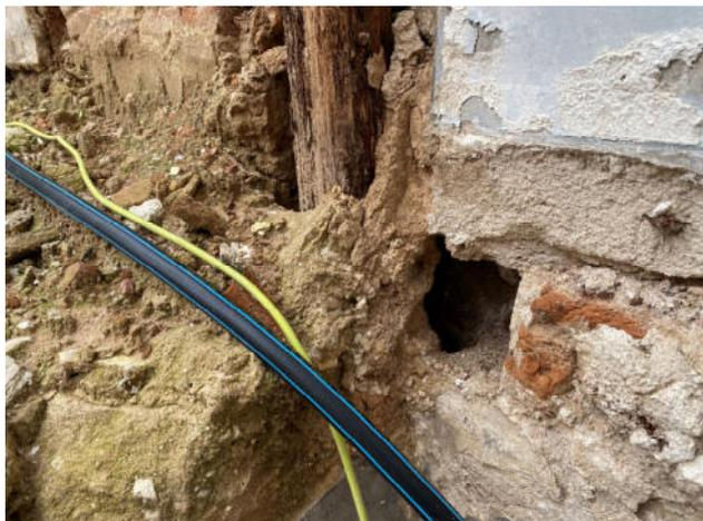
Fig.07 Huecos en muro de sótano de mampostería
