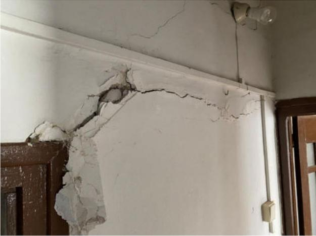
Fig.11. Planta cuarta. Grieta horizontal en rellano con inicio en punto de entalla de la puerta de entrada a la estancia 02
