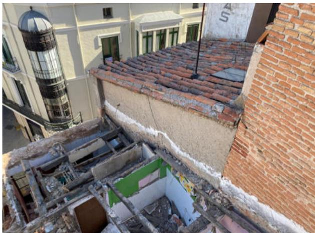
Fig.93. Faldón de cubierta hundido entre vigas de cubierta
