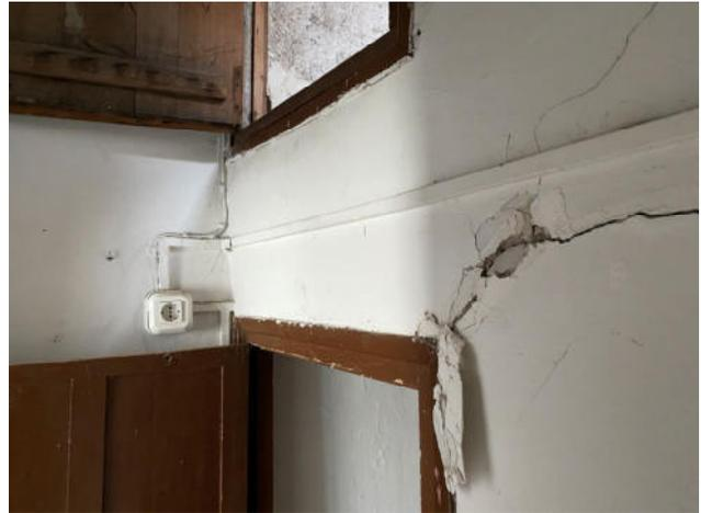
Fig.110. Instalación eléctrica por canaleta exterior para la conexión de un enchufe colocado en superficie
