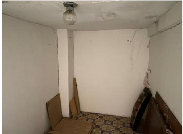
Fig.74. Grieta interior en medianera con desarrollo desde el borde de la cubierta a la planta cuarta
