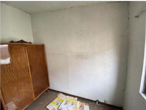
Fig.75. Grietas reparadas y sin reparar en la medianera de la estancia 01 de la planta cuarta
