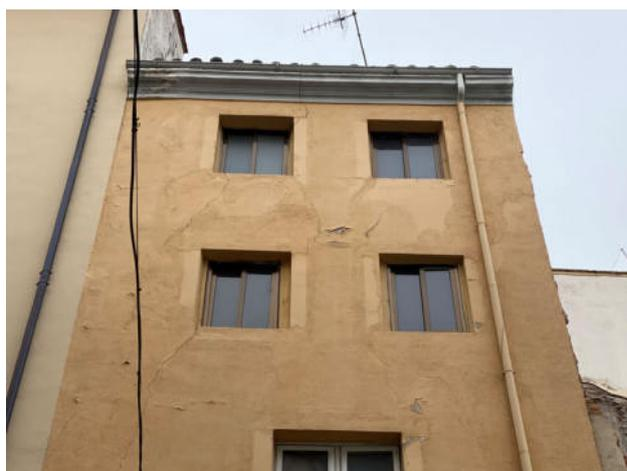
Fig.82. Detalle de las fisuras del enfoscado en la planta tercera y cuarta
