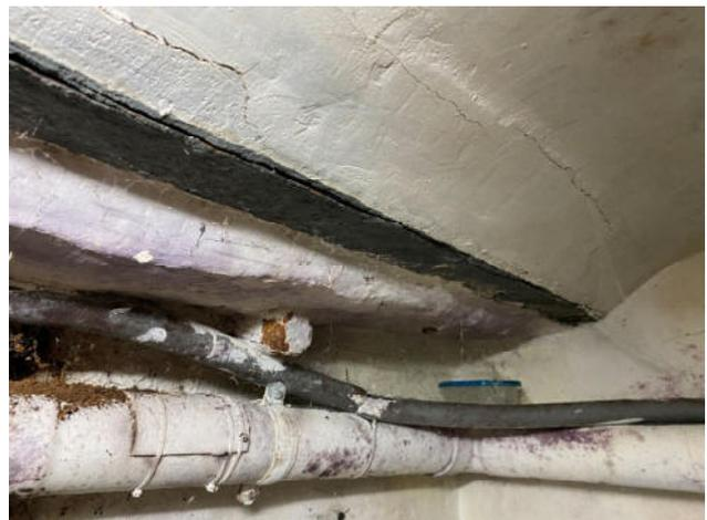
Fig.46. Daños por oxidación en el ala inferior de la vigueta que soporta el forjado en planta baja y en la bovedilla
