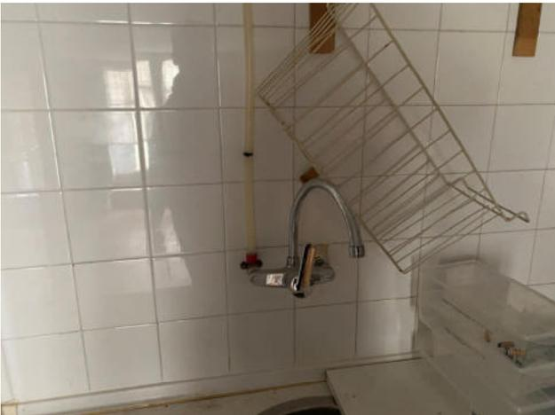
Fig.103. Suministro de agua en cocina con el tubo del ACS por el exterior
