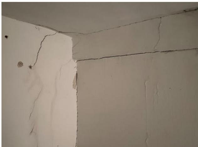
Fig.21. Planta cuarta. Grieta diagonal en medianera derecha y grieta de separación en encuentro con tabique en estancia 02
