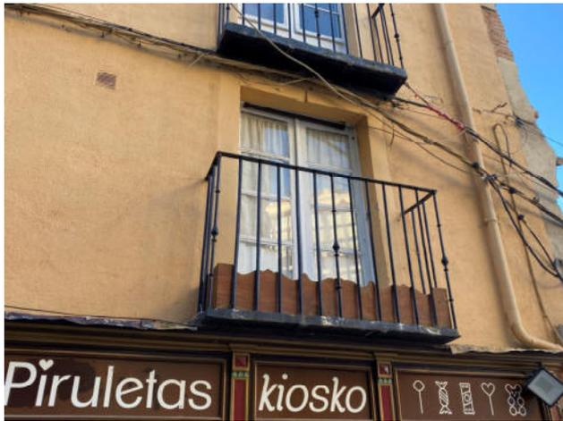
Fig.89. Pintura en losa de balcón metálica sobre oxido en la planta primera
