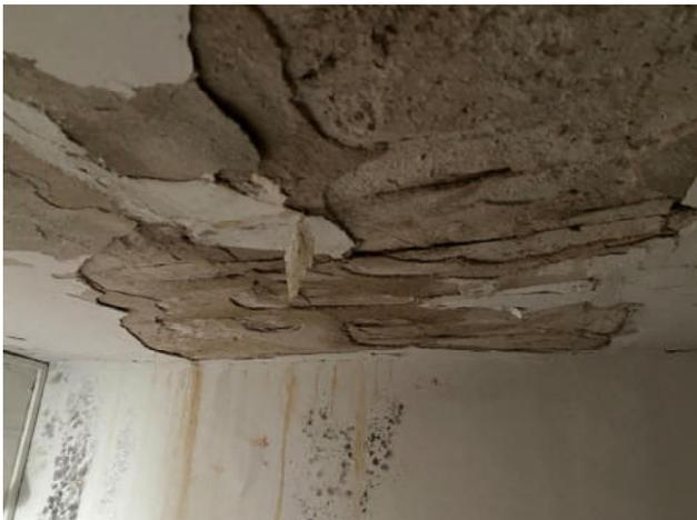
Fig.53. Daños en falso techo de estancia 02 ubicado bajo la zona del bajocubierta
