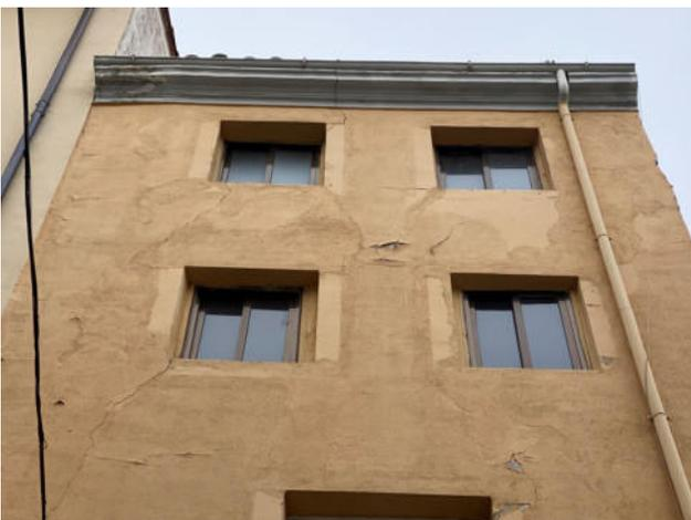
Fig.05 Grietas en la parte central de las cuatro ventanas
