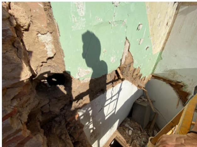
Fig.80. Vista exterior del agujero realizado durante las labores de derribo del edificio medianero en el que se aprecia que no existe aislante ni trasdosado en los muros y lateral de fachada que coincide en espesor en el interior de las estancias
