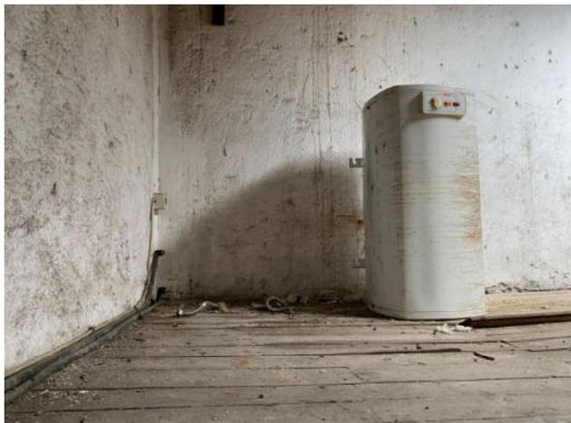
Fig.115. Instalación de termo para ACS con el termo sin conectar en la planta bajocubierta
