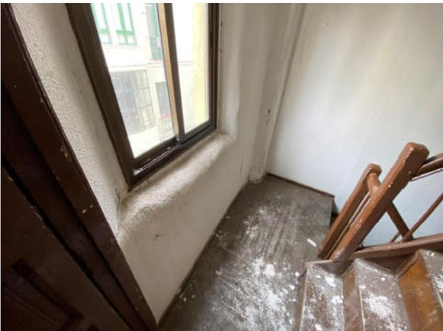
Fig.119. Altura de peto de ventaja a escasa altura con respecto al suelo terminado en planta tercera
