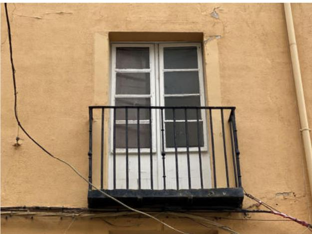
Fig.87. Deformación de las hojas de la carpintería de madera de la planta segunda
