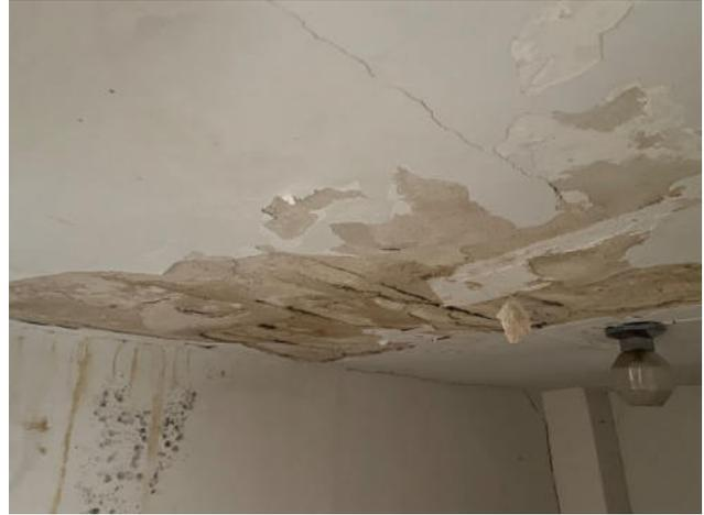
Fig.168. Daños en falso techo por humedad en estancias 02 de la planta cuarta
