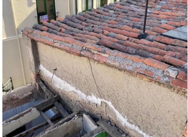
Fig.95. Detalle de tejas dañadas en remate de cubierta repuesto con mortero de cemento
