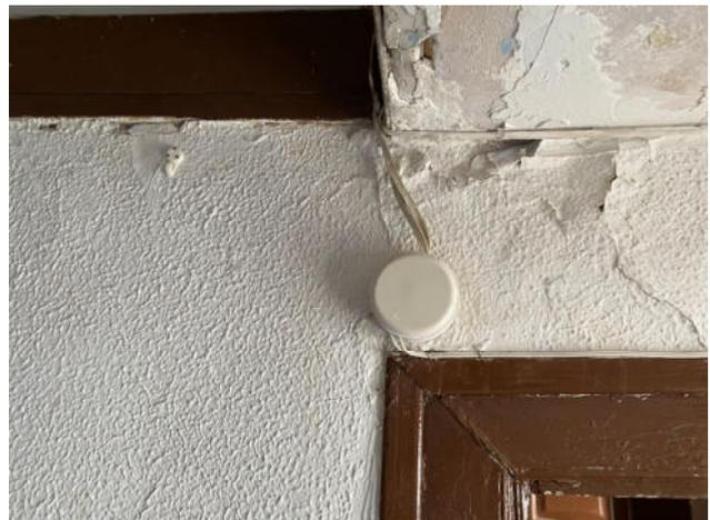
Fig.114. Caja de reparto en superficie con cables de grapados por el exterior de los tabiques
