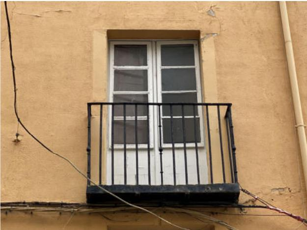
Fig.144. Falta de mantenimiento de carpintería en planta segunda
