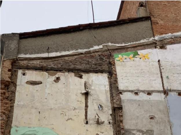
Fig.73. Recorrido de la grieta desde el borde de la cubierta hasta la planta cuarta
