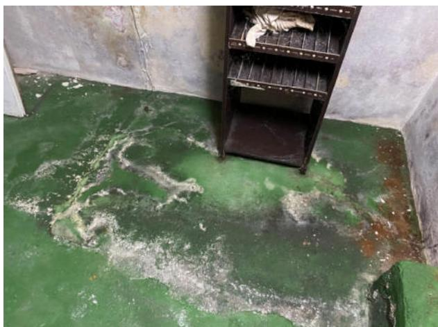
Fig.40. Restos de humedad en suelo provenientes del nivel freático del terreno
