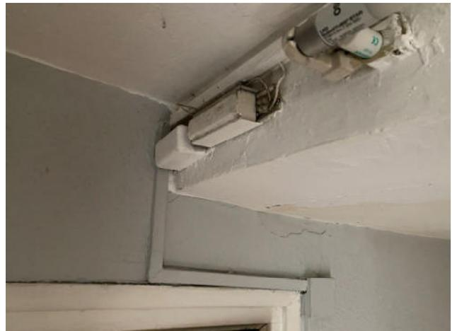
Fig.112. Instalación a la vista de transformadores para lámparas fluorescentes
