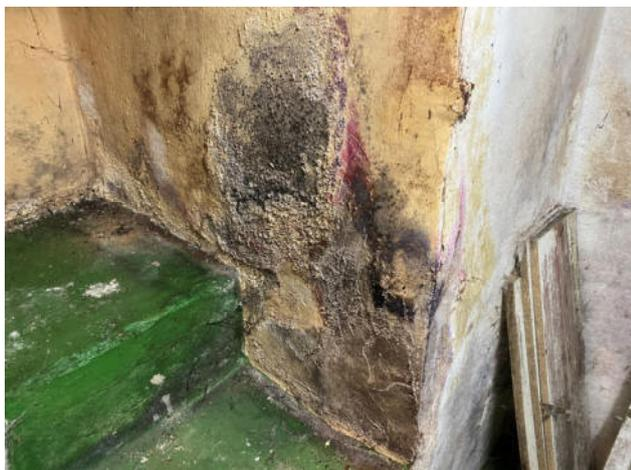
Fig.41. Restos de humedad en el muro del arranque de la escalera que ha producido daños en el acabado del mismo
