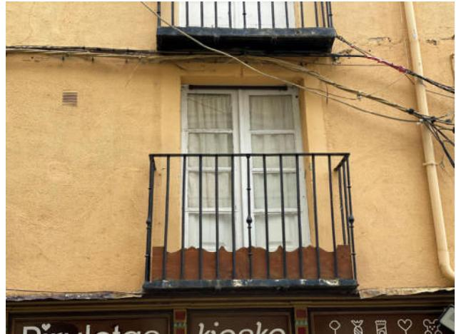
Fig.145. Falta de mantenimiento de carpintería en planta primera
