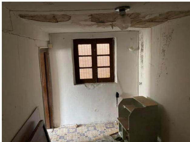
Fig.132. Altura libre inferior a 2,00 m en planta cuarta
