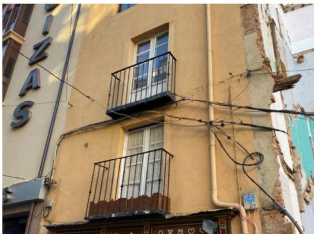
Fig.150. Cableados en la fachada a la altura de la planta segunda
