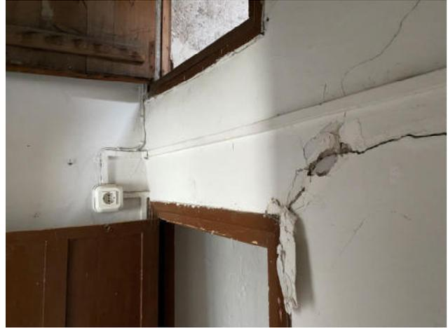
Fig.12. Planta cuarta. Grieta horizontal en rellano con inicio en punto de entalla de la puerta de entrada a la estancia 02
