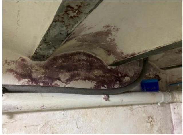
Fig.44. Daños por oxidación en el ala inferior de la vigueta que soporta el forjado en planta baja
