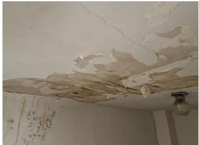
Fig.54. Daños en falso techo de estancia 02 ubicado bajo la zona del bajocubierta
