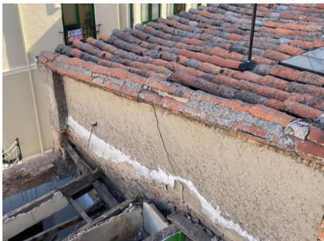
Fig.71. Grietas exteriores en arranque de cubierta y grieta en el punto de unión entre la fachada y la medianera
