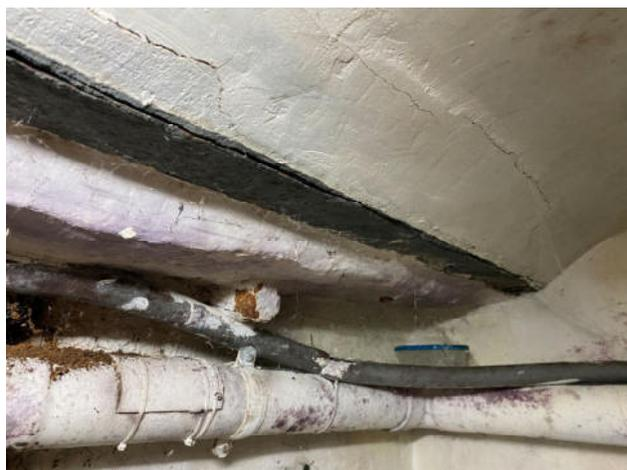
Fig.106. Recorrido de colector de aguas residuales por el techo del sótano hasta arqueta
