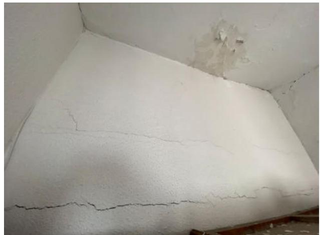
Fig.14. Planta cuarta. Grieta horizontal en estancia 01 en tabique de separación con estancia 02
