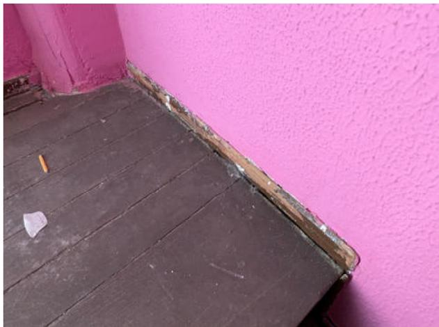
Fig.57. Detalle desplazamiento hacia la derecha (izquierda en la foto) de escalera entre P01-P02
