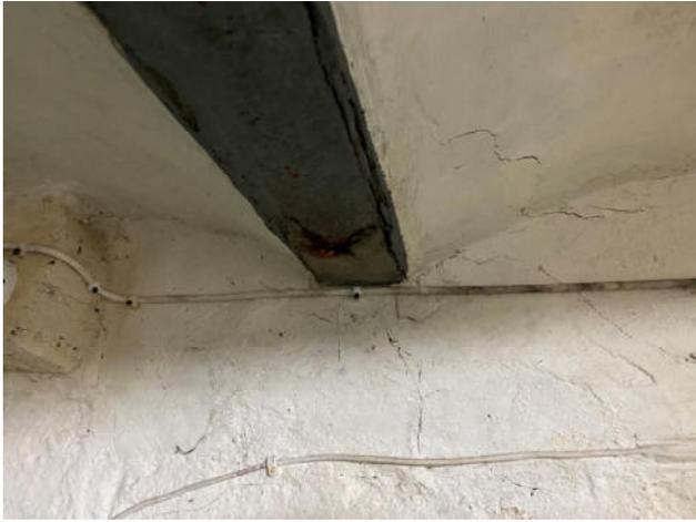
Fig.43. Daños por oxidación en el ala inferior de la vigueta que soporta el forjado en planta baja
