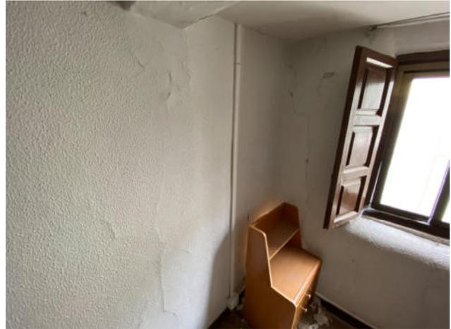
Fig.24. Planta tercera. Grietas en pared medianera derecha y fachada principal en estancia diáfana
