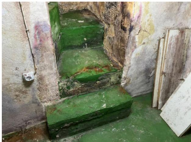
Fig.174. Daños por humedad en sótano de edificio proveniente del nivel freático del terreno
