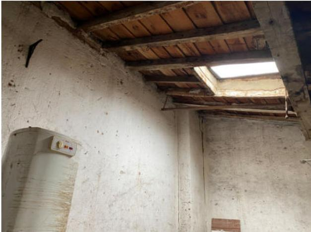
Fig.51. Restos de humedades en zona de lucernario de cubierta
