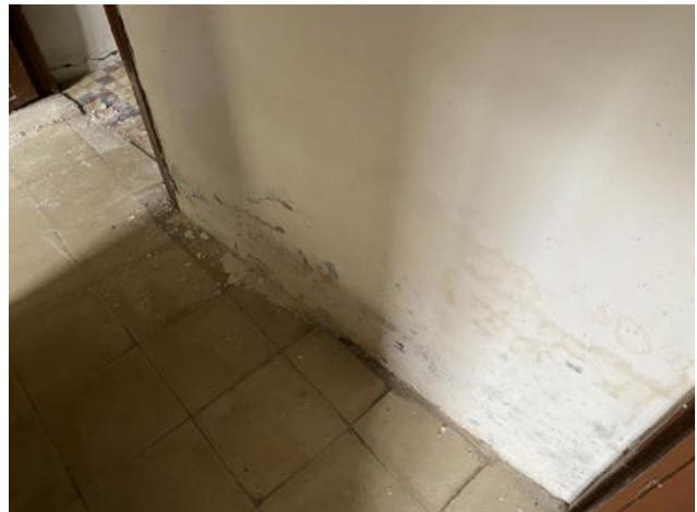
Fig.170. Manchas por humedad en apoyo de los tabiques en la planta cuarta
