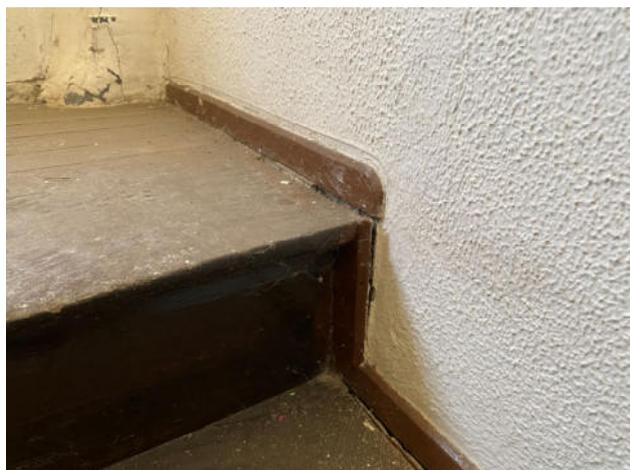
Fig.62. Detalle de desplazamiento en el que se ha separado el rodapié de la escalera
