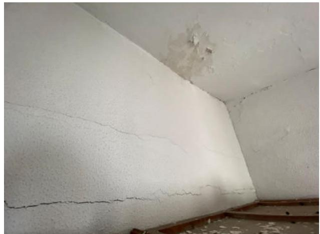
Fig.56. Restos de daños de humedad proveniente de cubierta en techo de estancia 01 sin reparar
