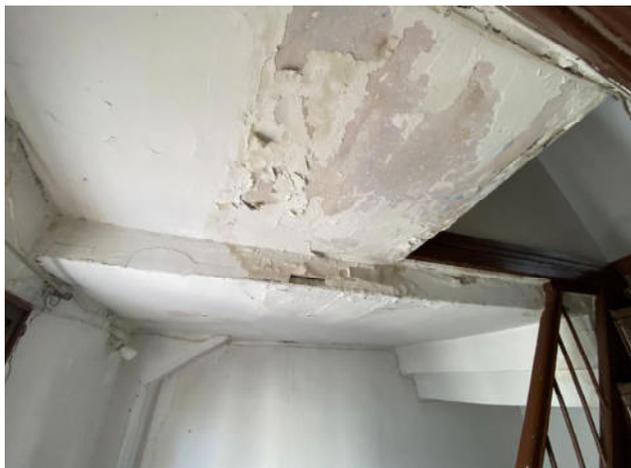
Fig.173. Daños en falso techo por humedad de la bañera ubicada en el baño de la planta cuarta
