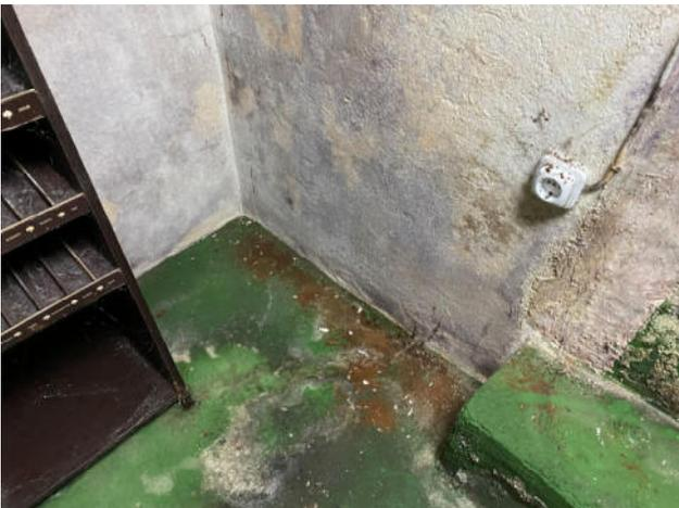
Fig.111. Instalación de un enchufe en el sótano del edificio en la humedad del muro
