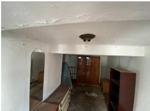
Fig.131. Altura libre inferior a 2,00 m en planta tercera
