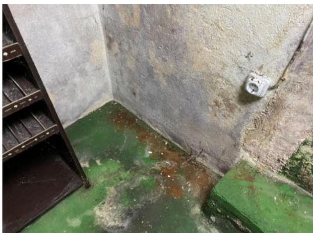
Fig.39. Restos de humedad en suelo y paredes proveniente del nivel freático
