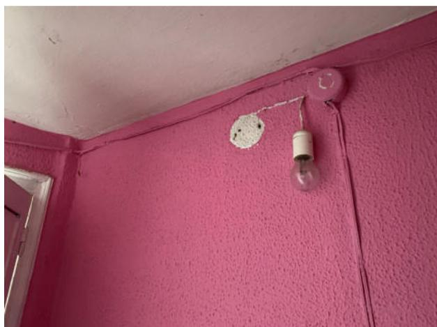
Fig.134. Bombilla colgada de un cable en escalera de subida a planta tercera
