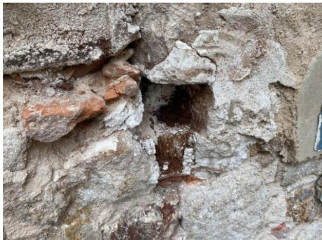
Fig.08 Huecos en muro de sótano de mampostería
