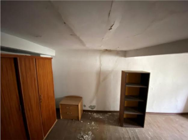
Fig.23. Planta tercera. Grietas en pared medianera derecha reparada y grietas en cielos rasos de caña y escayola en estancia
