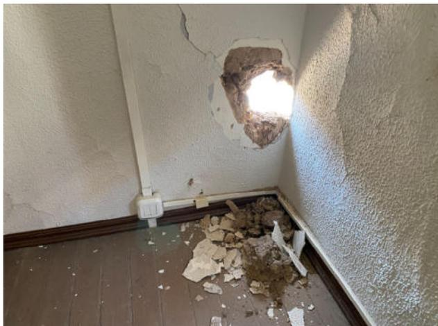
Fig.79. Vista interior del agujero realizado durante las labores de derribo del edificio medianero en el que se aprecia que no existe aislante ni trasdosado en los muros
