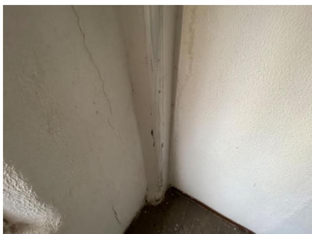
Fig.108. Bajante de aguas residuales sin cubrir por esquina izquierda de la fachada
