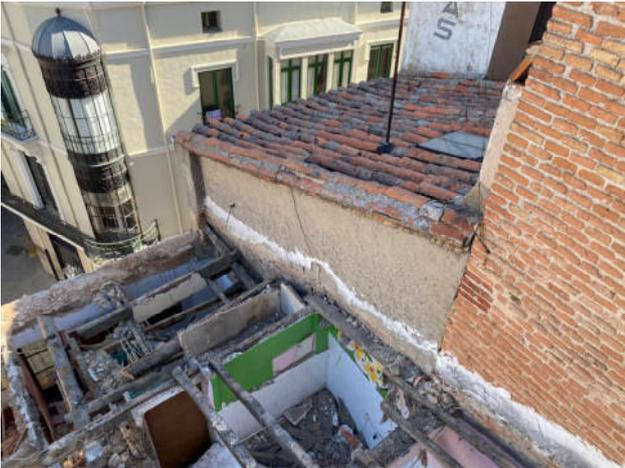
Fig.85. Fisuras y degradación del enfoscado medianero visto debido a las grietas en el muro
