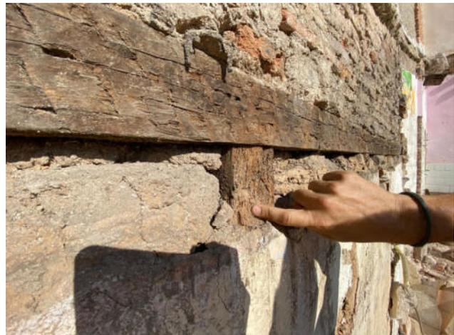
Fig.36. Vista detalle de un pilarote unido a una carrera atacado por insectos xilófagos
