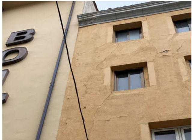
Fig.66. Grietas en puntos de entalla de las ventanas de P04 y P03
