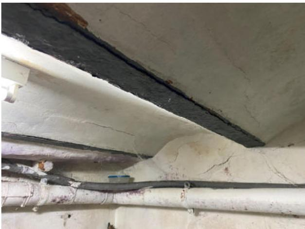
Fig.45. Daños por oxidación en el ala inferior de la vigueta que soporta el forjado en planta baja y en la bovedilla
