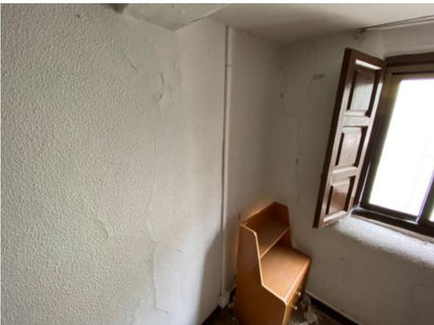
Fig.77. Grietas sin reparar en la medianera de la estancia 01 de la planta tercera
