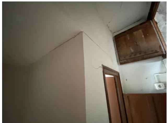
Fig.16. Planta cuarta. Grieta horizontal en tabique de separación de rellano y escalera con el baño
