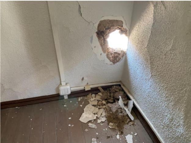
Fig.99. Medianera derecha sin ningún tipo de aislamiento térmico vista desde el interior, lo que se puede interpolar a todo el inmueble
