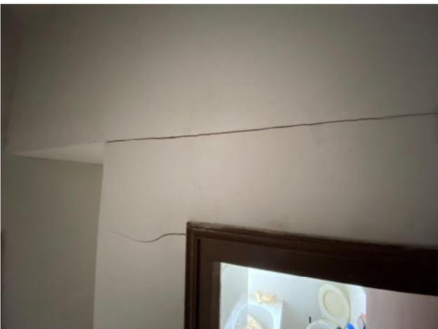
Fig.15. Planta cuarta. Grieta horizontal en tabique de separación de rellano y baño e inicio de grieta en esquina superior de puerta
