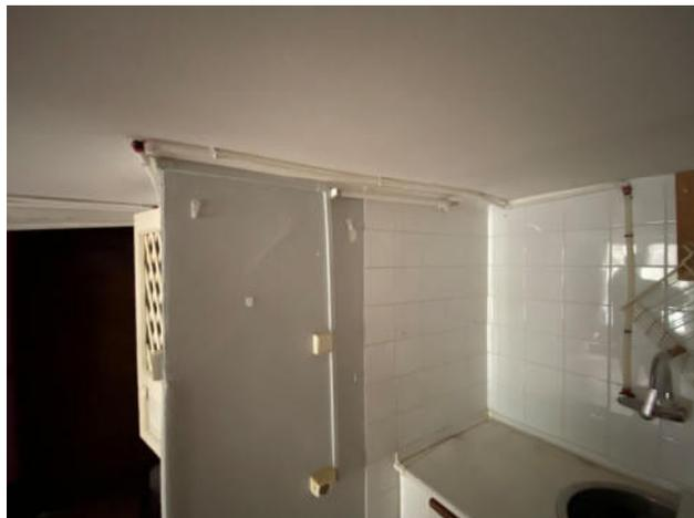
Fig.116. Instalación para el ACS de la cocina colocada en superficie para conexión a grifo
