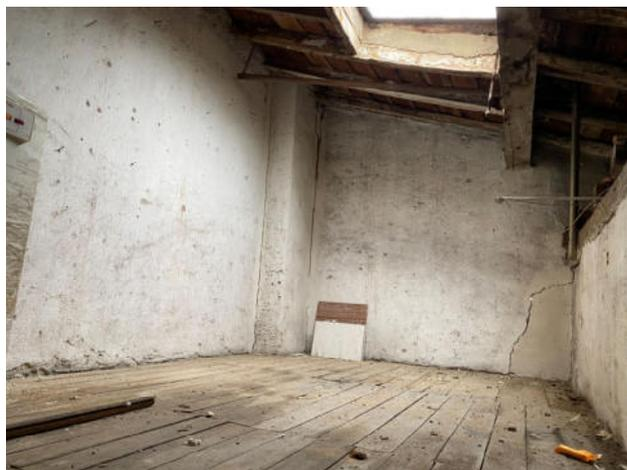
Fig.72. Grieta interior en medianera en planta bajocubierta a través de la cual puede observarse la luz del exterior
