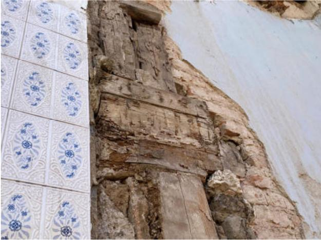
Fig.33. Vista detalle de zapata sobre pie derecho que soporta la carrera atacada por insectos xilófagos
