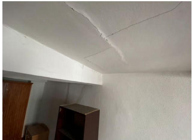
Fig.26. Planta tercera. Grietas en cielos rasos de caña y escayola paralelas a la medianera derecha
