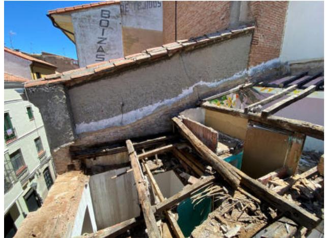
Fig.86. Fisuras y degradación del enfoscado medianero visto debido a las grietas en el muro
