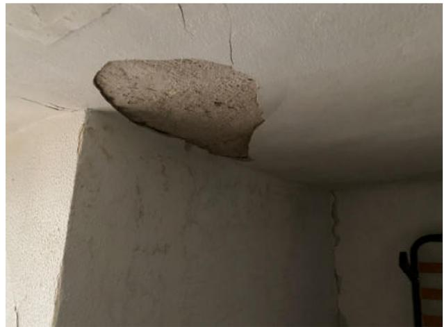
Fig.172. Daños en falso techo por humedad en estancias 02 de la planta tercera
