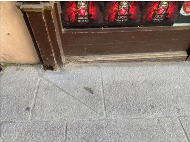
Fig.146. Falta de mantenimiento en carpinterías de madera del escaparate
