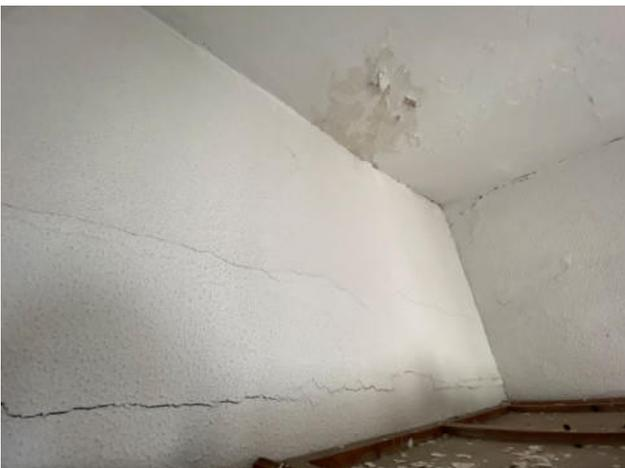
Fig.96. Daños en cielo raso de estancia 01 por filtraciones de cubierta
