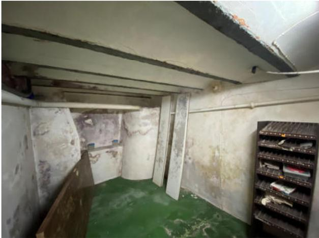
Fig.135. Vista general del sótano sin elementos de ventilación
