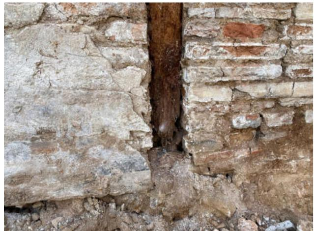
Fig.30. Vista detalle de pilarote de madera atacado por insectos xilófagos y sin apoyo en el muro de mampostería
